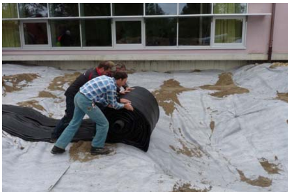
Abb. 5: Das Ausrollen der vorkonfektionierten Folie aus EPDM Kautschuk. Als zusätzlicher Schutz für die Folie wurde über die Sandschicht ein Vlies gelegt und mit einigen Schaufeln Sand fixiert. Foto: Markus Kutzli
