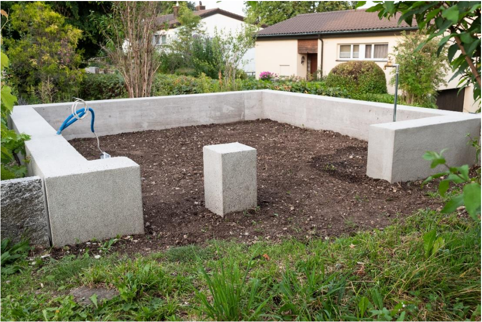
Das fertige Fundament mit eingebauten Wasser- und Stromanschlüssen.
