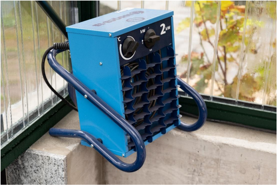
Zwei Heizlüfter sorgen für die Beheizung des Gewächshauses.
