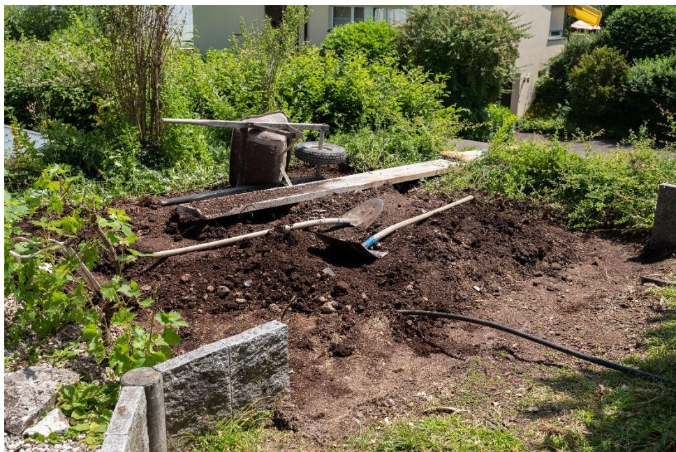
Nach Abbruch des alten Gewächshauses.
