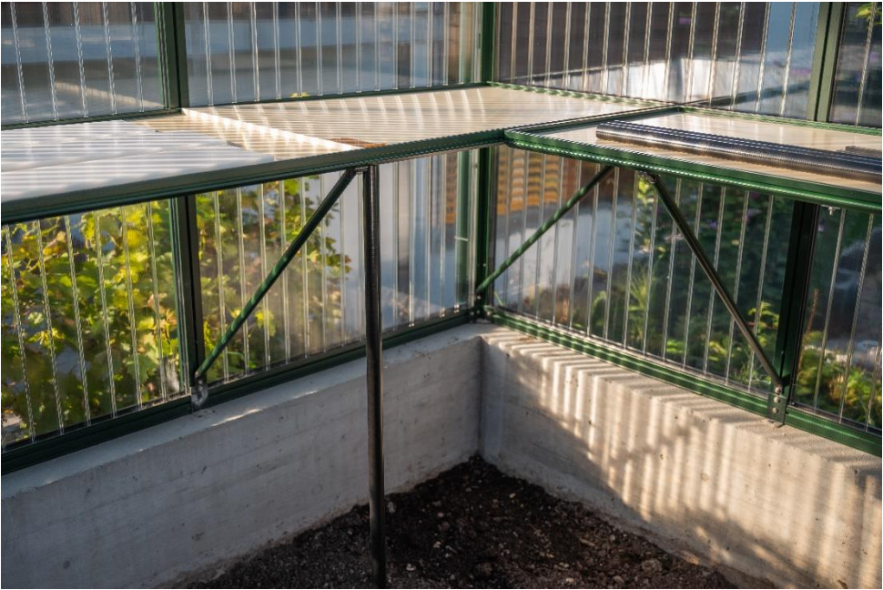
Die Pflanzentische wurden an den Wänden befestigt und mit Säulen abgestützt.
