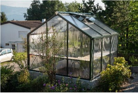
Das fertige Gewächshaus.
