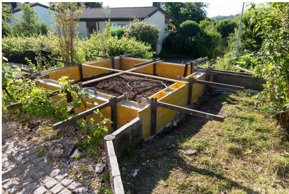
Betonierung des Fundaments.
