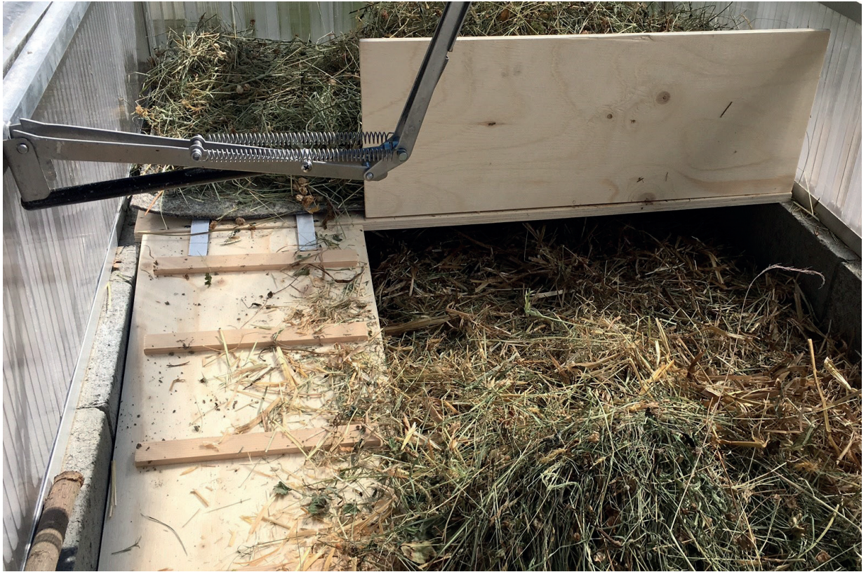
Die Frühbeete werden montiert und der Unterbau mit Erdsandgemisch aufgefüllt. Ausserdem wurde ein Unterschlupf mit Sonnenbank gebaut.
