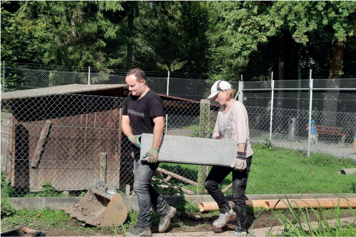
Nur durch freiwillige Helfer konnte der Umbau realisiert werden.
