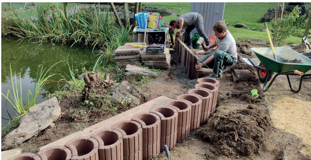
Die neue Umrandung entsteht.
