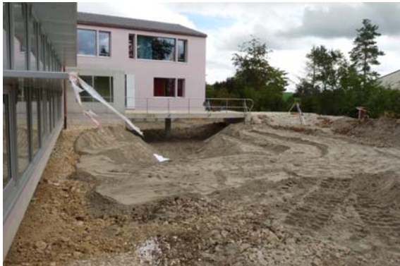
Abb. 4: Zum Schutz der Folie wird eine schützende Sandschicht aufgetragen. Foto: Markus Kutzli
