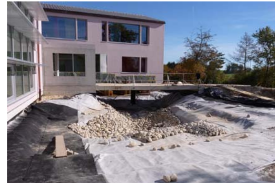
Abb. 7: Eine zweite Schutz-Vliesschicht wurde auf der Folie ausgebreitet. Ausgehend von der tiefsten Stelle wird die ganze Folie mit einer Lage aus Bollensteinen bedeckt. Die Räume zwischen den Bollensteinen werden mit Birskies ausgefüllt. Foto: Markus Kutzli
