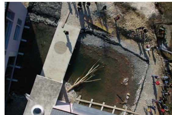
Abb. 8: Blick von oben auf den Teich. Gut sichtbar die senkrecht aufgestellten Folienränder, welche nun mit Bollensteinen fixiert werden. Damit kann der Wasserverlust durch Kapillarität verhindert werden. Die Folienränder wurden erst abgeschnitten, als der Teich sich mit Wasser füllte. Foto: Markus Kutzli
